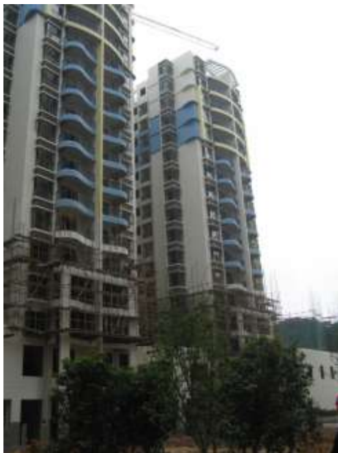
工程形象進度照片
